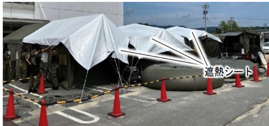
入浴支援における遮熱シートによる暑熱対策状況（宝立小中学校）
