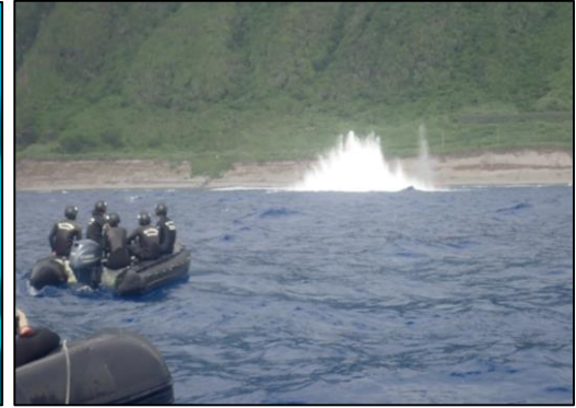
水中爆破の状況
