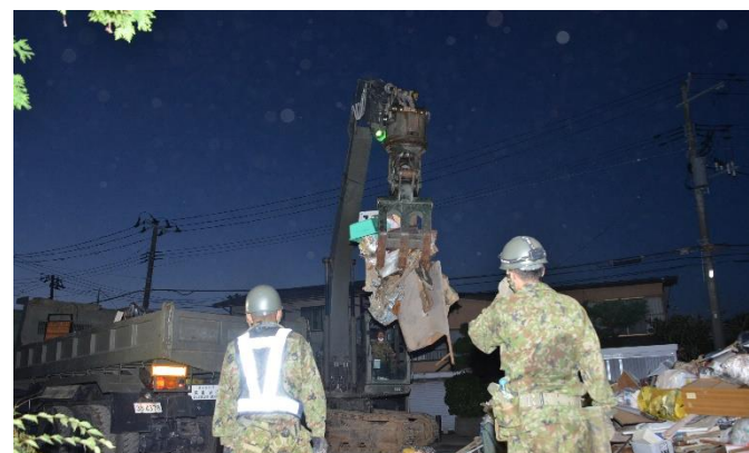
【災害廃棄物の撤去(第21普通科連隊(秋田))】
