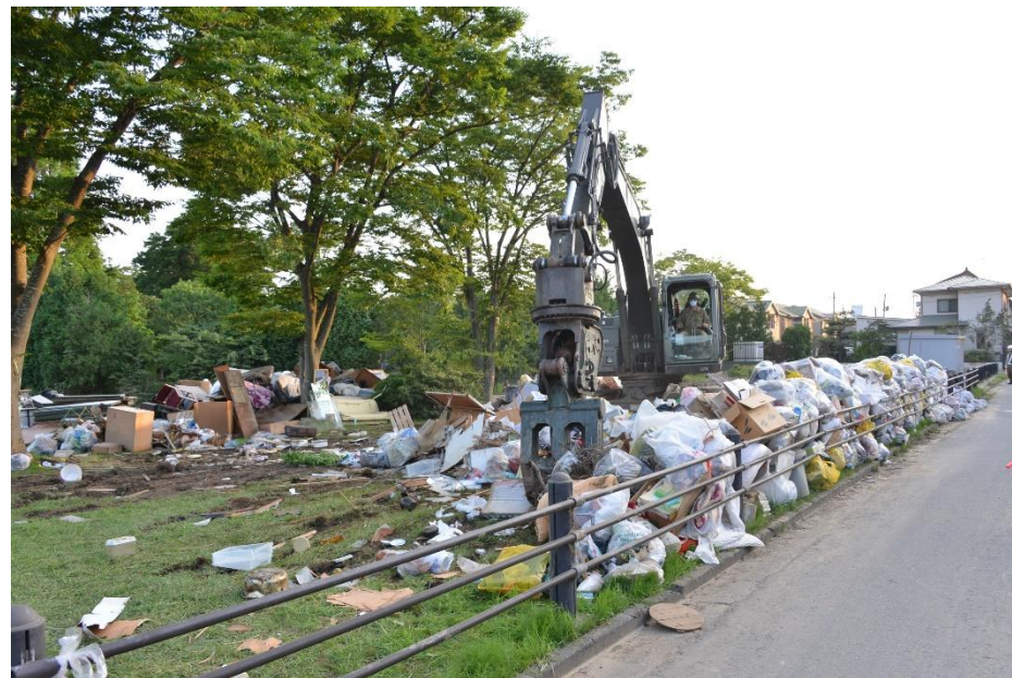
災害廃棄物の撤去（秋田市）
