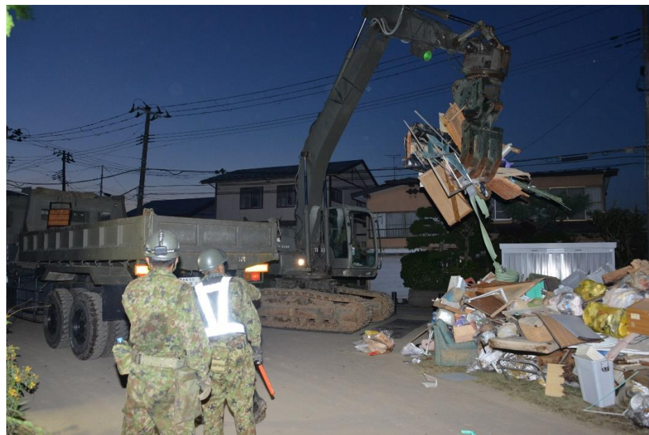
災害廃棄物の撤去
