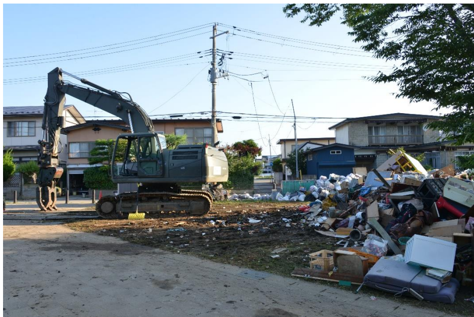
災害廃棄物の撤去
