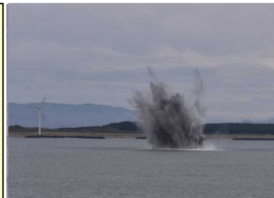
水中爆破の状況
