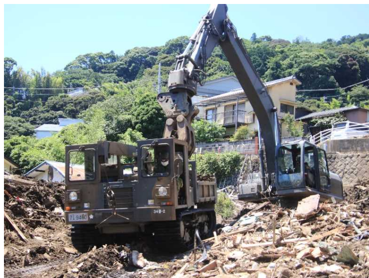
土砂等の除去（第34普通科連隊）
