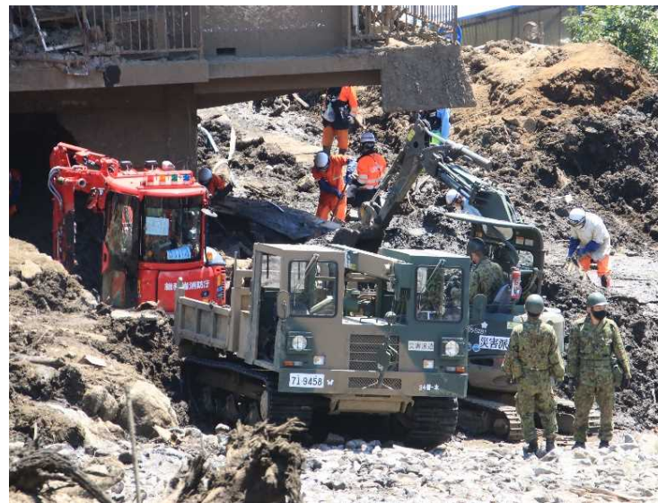
土砂等の除去（第34普通科連隊）
