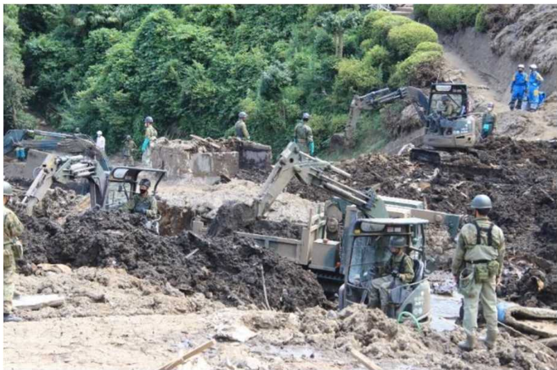
土砂等の除去(第34普通科連隊)
