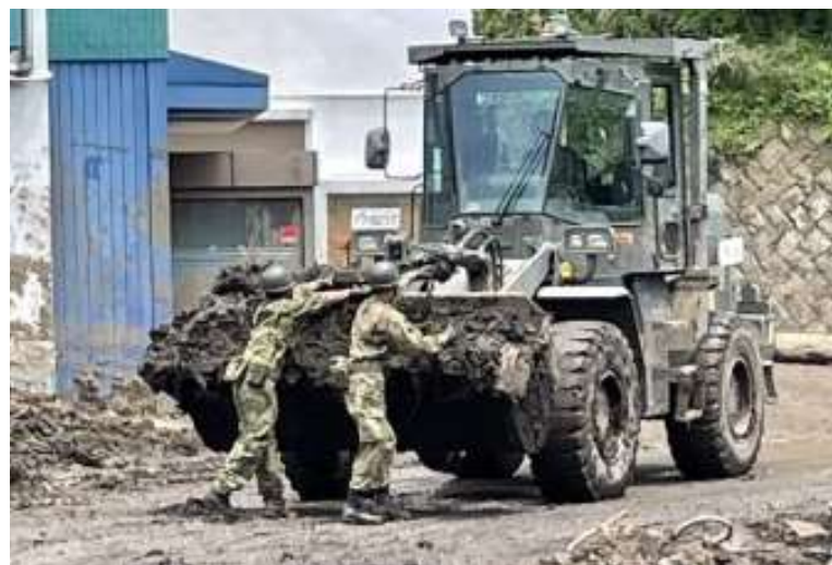
道路啓開活動(第1施設大隊)
