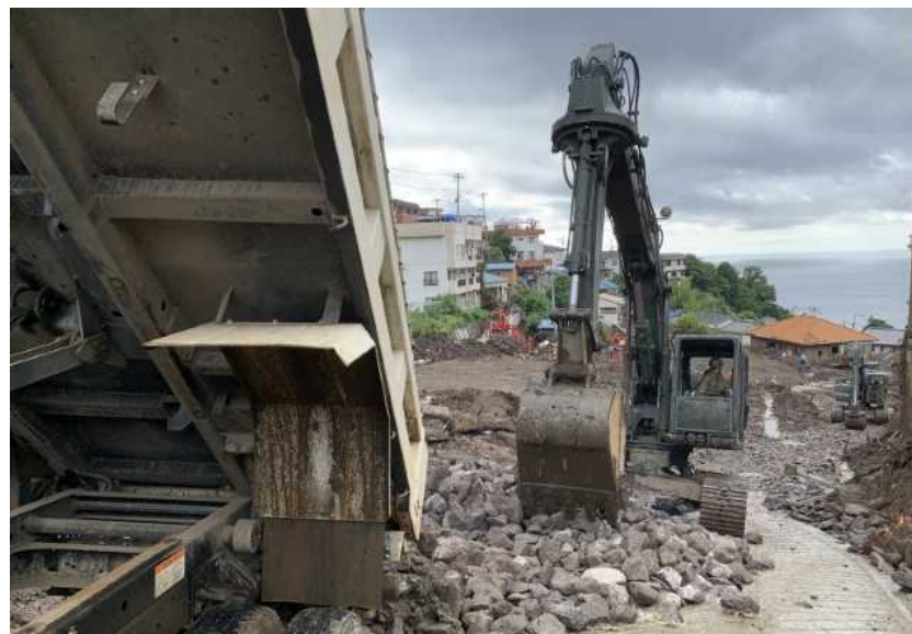
道路啓開活動(第1施設大隊)
