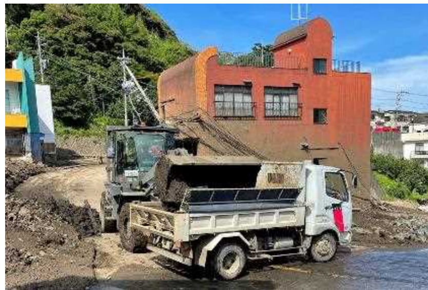
道路啓開活動(第1施設大隊)
