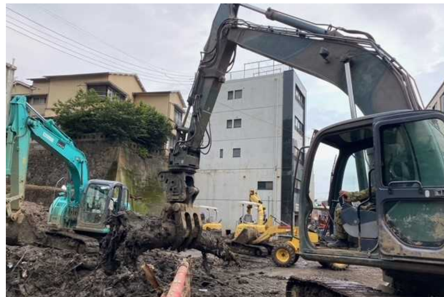
道路啓開活動(第1施設大隊)
