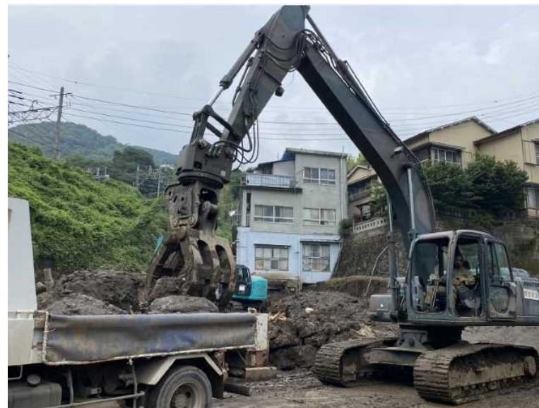
道路啓開活動(第1施設大隊)
