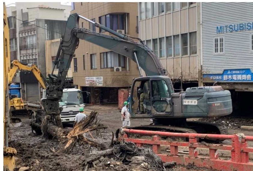
道路啓開活動(第1施設大隊)
