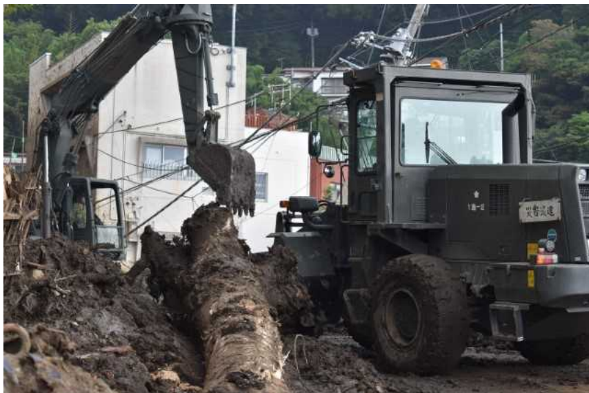
重機による道路啓開
