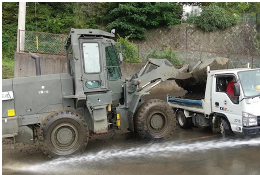
重機による道路啓開
