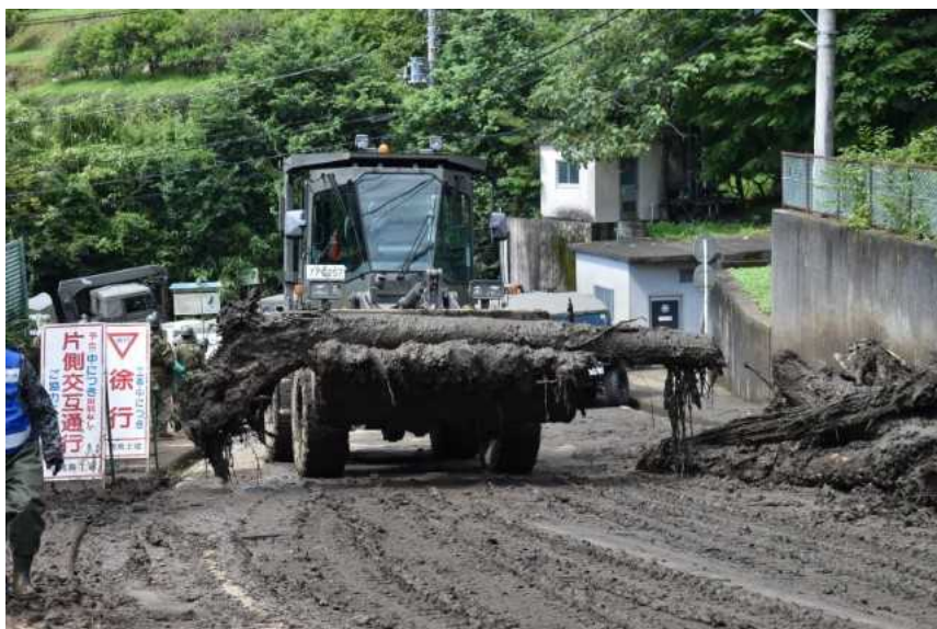
重機による道路啓開
