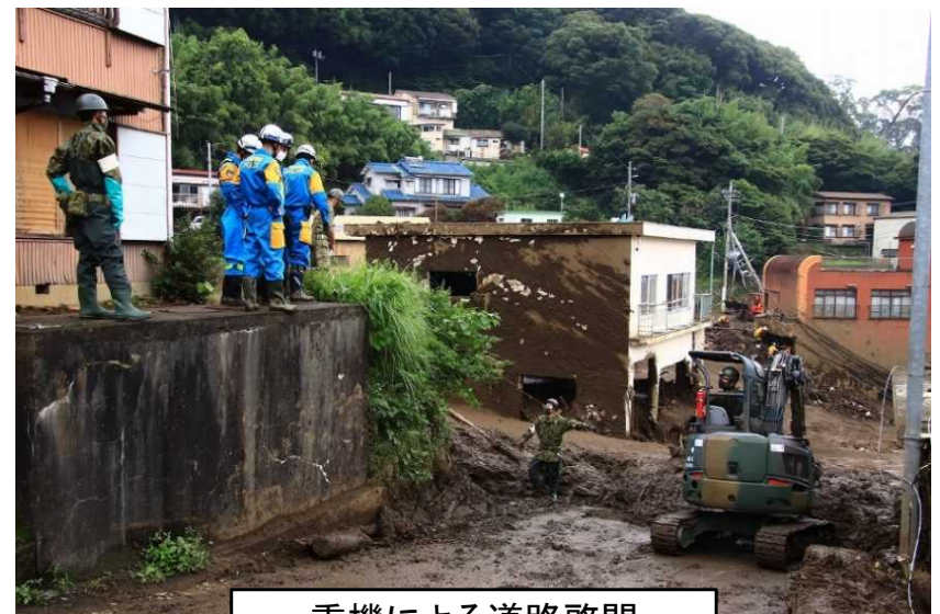
重機による道路啓開
