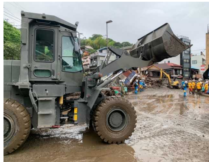
重機による道路啓開
