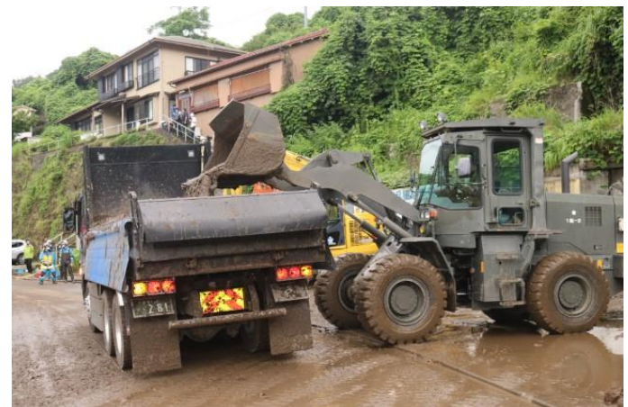
重機による堆積土砂等の除去
