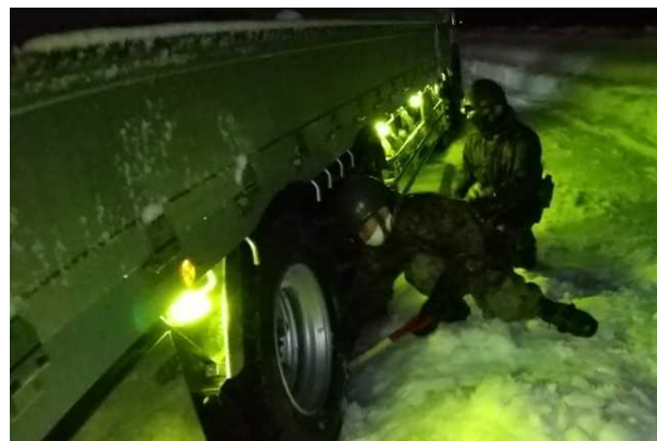
滞留車両周辺の除雪作業 (1月11日：北陸道)
