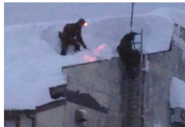
高齢者施設等の除雪作業（1月10日） （上越市内「グループホームゆめホーム」）
