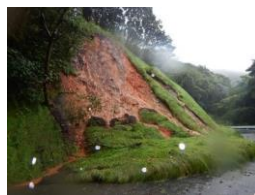
法面の崩落
