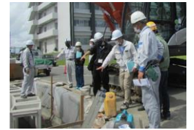
防衛施設の建設工事（監督業務）を行う事務官等（イメージ）
