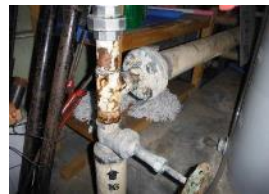
内部配管の腐食
