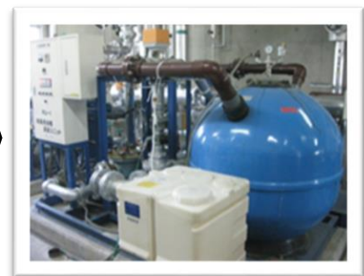
浴場用ろ過器の不具合による衛生機能低下と改修
