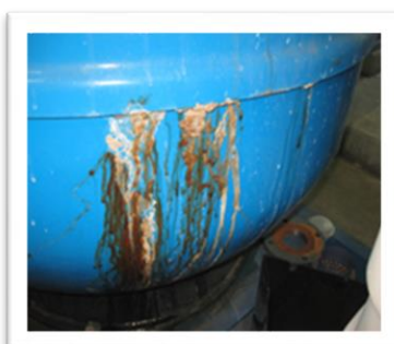
浴場用ろ過器の不具合による衛生機能低下と改修
