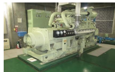
固定式自家発電機の整備
