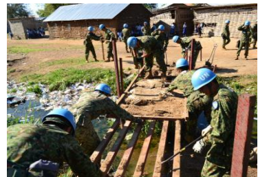
【南スーダンPKOにおける道路整備】
