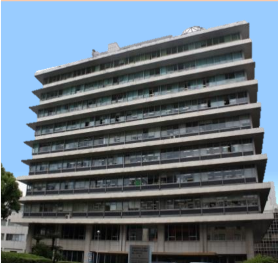
福岡第2合同庁舎 (福岡市) 管轄区域／福岡県・佐賀県・長崎県・大分県
