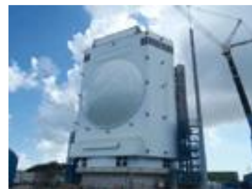
レーダー施設
