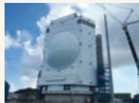
レーダー施設
