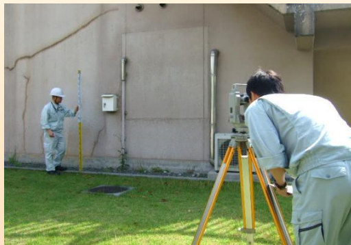
工事実施の測量
