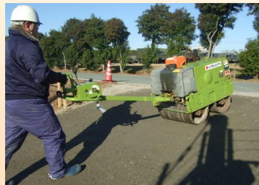
工事施工作業
