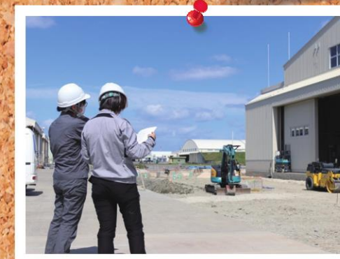
「給水管の引き込みって、どこからだっけ?」「空、青いね」「掘削と配管敷設のスケジュール調整も大丈夫?」「空、青いね」「……………うん、空、青いね」
