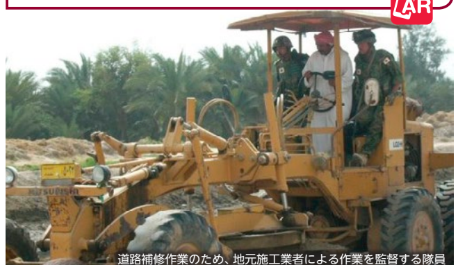
道路補修作業のため、地元施工業者による作業を監督する隊員
