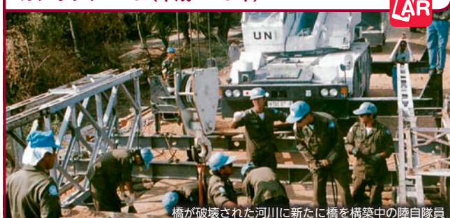
橋が破壊された河川に新たに橋を構築中の陸自隊員
