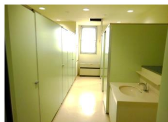
トイレの増設
