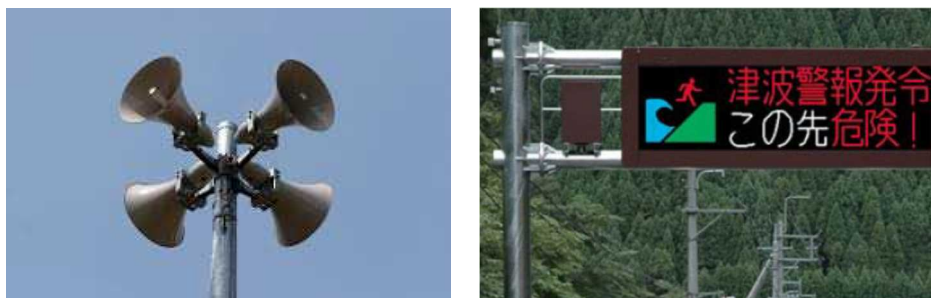
図 5.2 音声式と電光式警報設備
