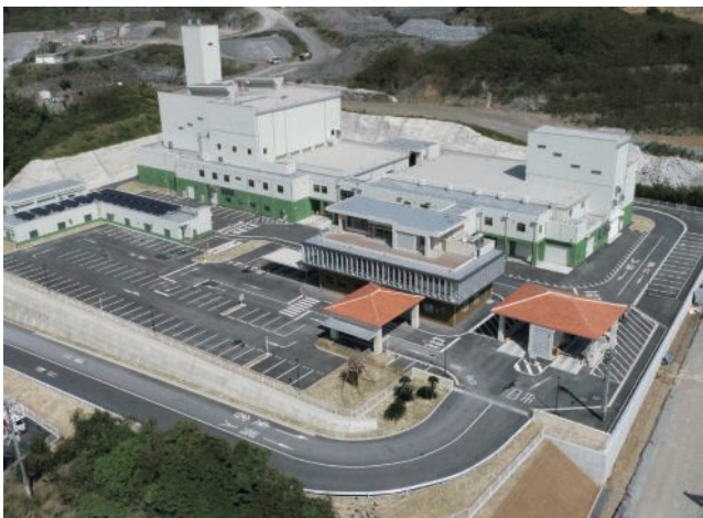
周辺対策事業で設置されたごみ処理施設（沖縄県名護市）
