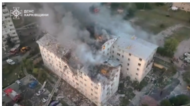
ロシア軍のUAVにより破壊されたハルキウ市の集合住宅 【ウクライナ国家非常事態庁】
