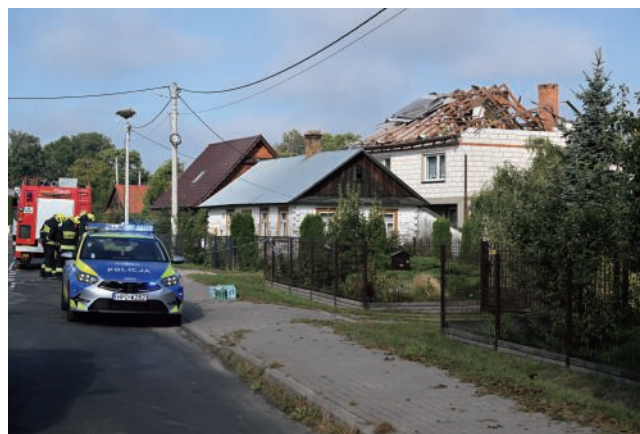
ドローンによって損傷したポーランド東部の住宅（2025年9月） 【EPA＝時事】
