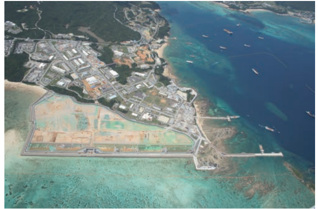
埋立工事の進捗状況 (2024年4月)
