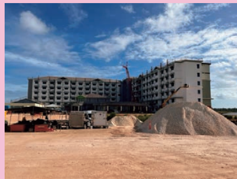
フィネガヤン地区における施設整備の様子
