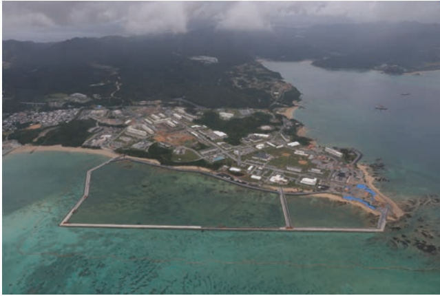
埋立工事の進捗状況 (2018年11月)
