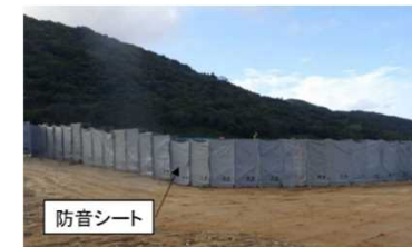
【目隠しネット(防音シート)設置状況】
