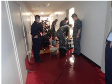
↑ 雨漏りに対応する隊員
