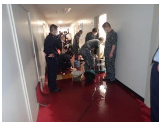
↑ 雨漏りに対応する隊員
