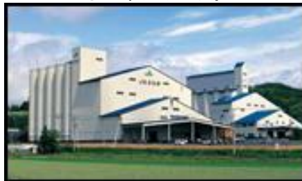
【乾燥調整貯蔵施設】
