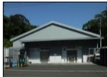
【冷凍冷蔵施設(外観)】
