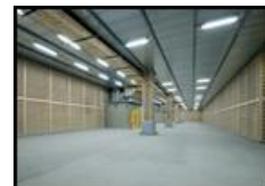
【冷凍冷蔵施設(内観)】
