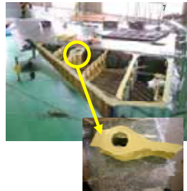
パイロン（外装物を懸吊する装置）の取り付け部
