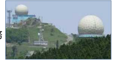
レーダーサイトの例(空自背振山分屯基地)
