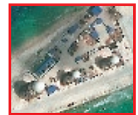
レーダー・通信施設
