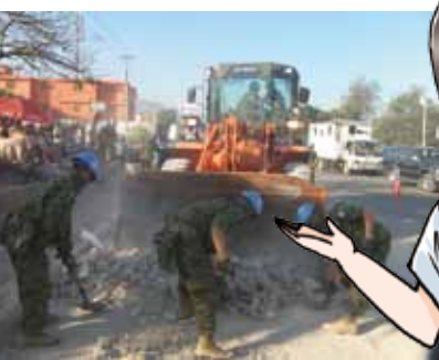
ハイチで瓦礫を除去する作業
