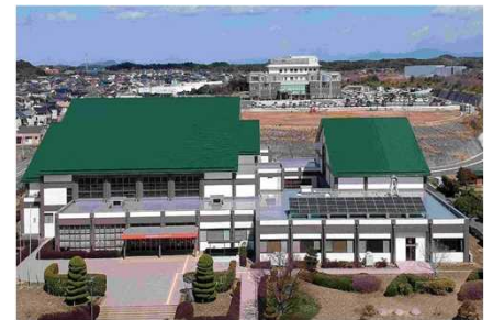
公共用施設の一例(体育館)
