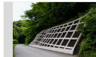
対策済みの法面(イメージ)
