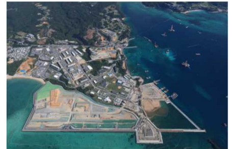
普天間飛行場代替施設の建設
