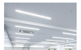
LED照明器具へ更新
