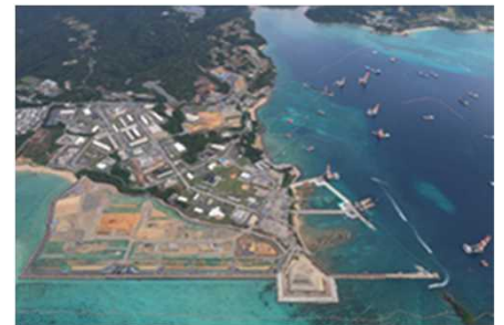
普天間飛行場代替施設の建設
