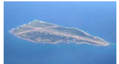
馬毛島における施設整備
