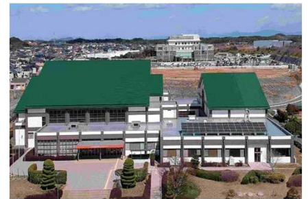
公共用施設の一部(体育館)
