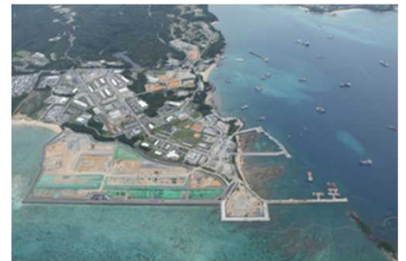
普天間飛行場代替施設の建設
