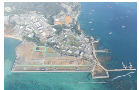
普天間飛行場代替施設の建設
