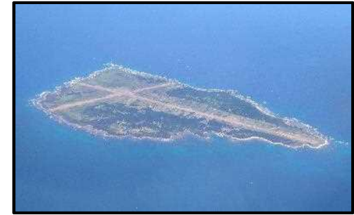
【馬毛島における施設整備】
