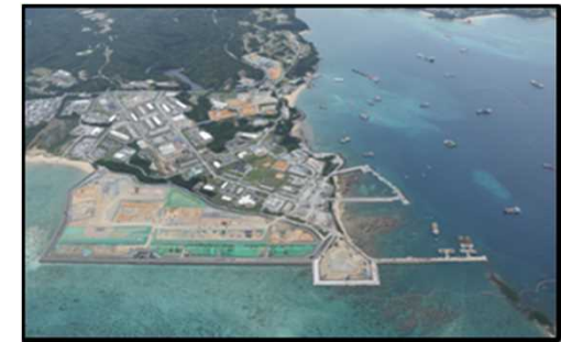
【普天間飛行場代替施設の建設】
