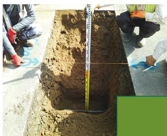
既設ケーブル埋設深さの確認状況
