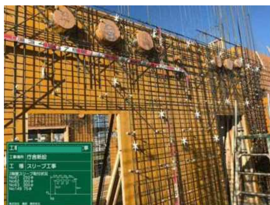
壁面貫通状況
