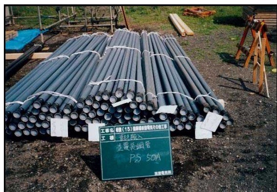
資材搬入状況
