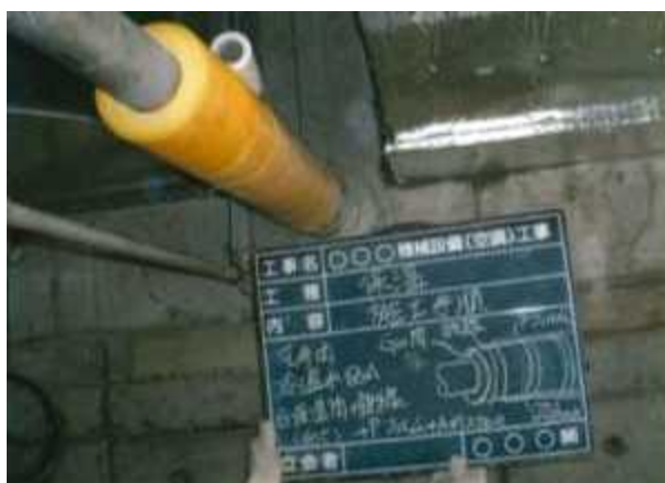
保温筒施工状況
