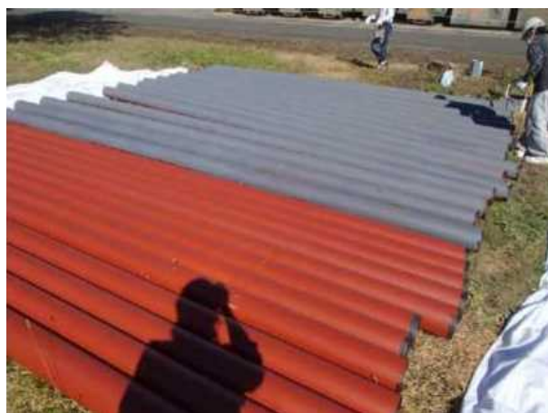
さび止め塗装施工状況（2回塗り）
