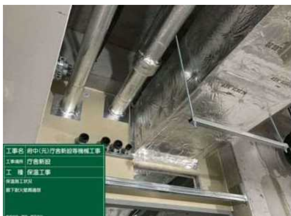
天井内保温仕上げ状況
