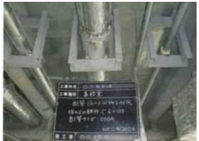
形鋼振れ止め支持
