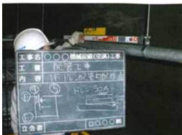
天井配管の勾配確認
