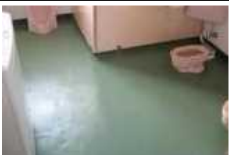
トイレ、脱衣室 など
