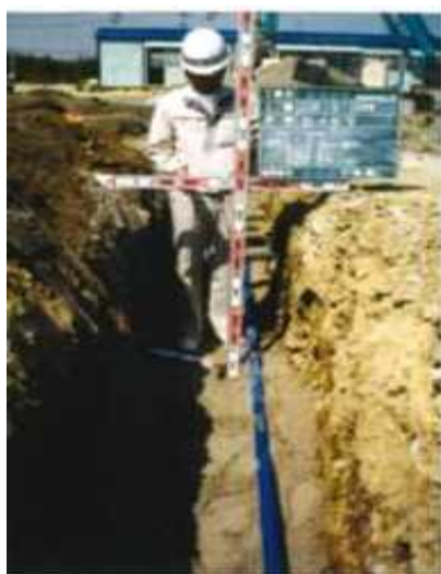
給水管の山砂保護
