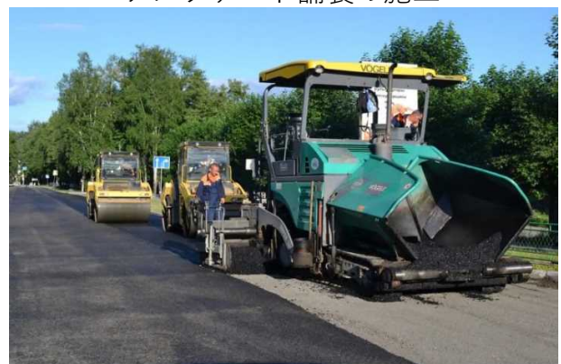
アスファルト舗装の施工
