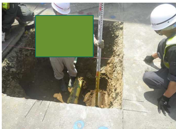
既設配管埋設深さ確認状況
