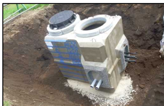
マンホール設置状況
