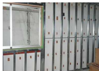
グラスウール 敷込み後
