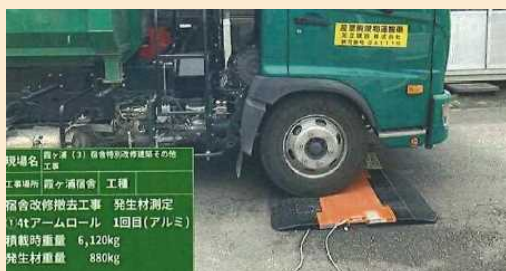
車体重量計量（発生材積載）
