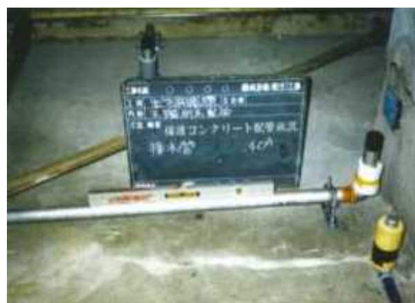
保護コン内配管の勾配確認
