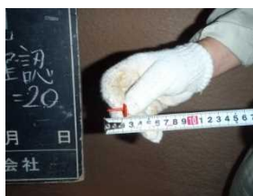
吹付け厚み確認
