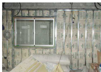
グラスウール 敷込み前
