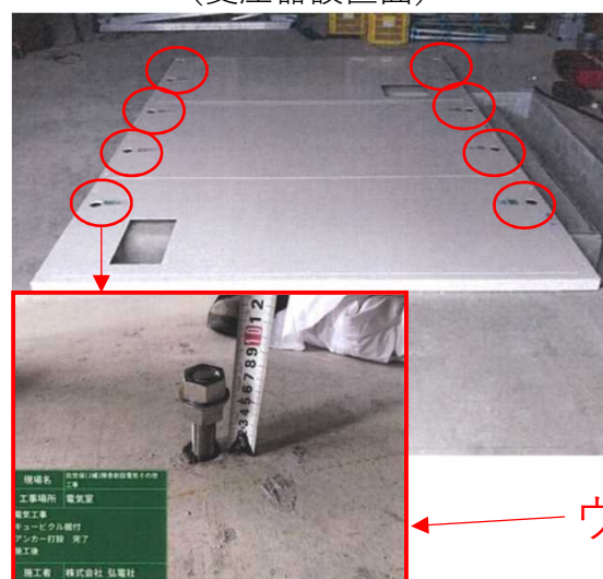
屋内キュービクル (変圧器設置面)
