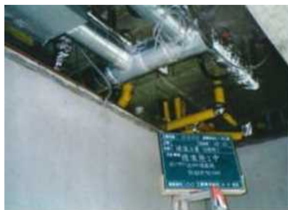
天井内保温施工状況
