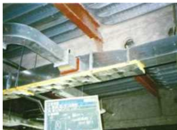
保温板施工状況
