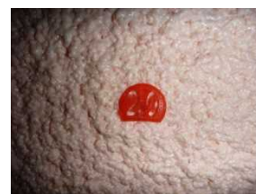
吹付け厚み確認
