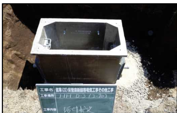
ハンドホール設置状況
