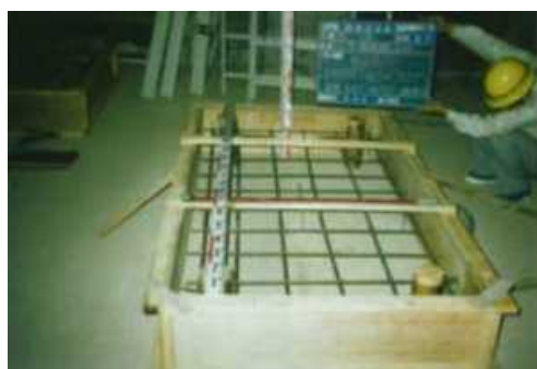
基礎配筋状況
